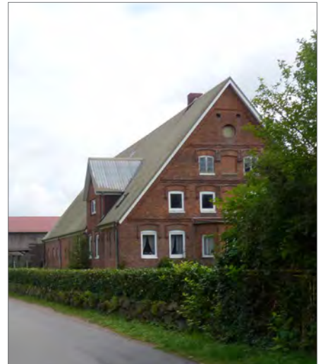
Abb. 16: Bebauung an der Hauskoppel
