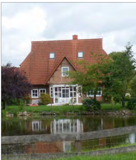
Abb. 17: Bebauung an der Hauskoppel
